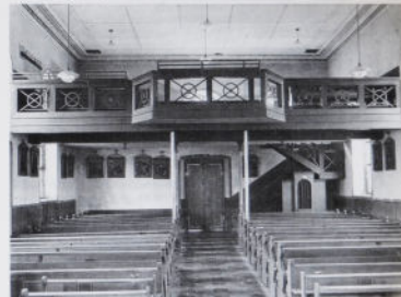
Blick zur Orgelempore vor der Renovation
