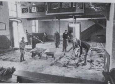
– Letzter Gottesdienst vor der Renovation: Patrozinium am 15. Juni 1985 – Aushub, damit die Bänke auf ein solides Fundament gestellt werden können
