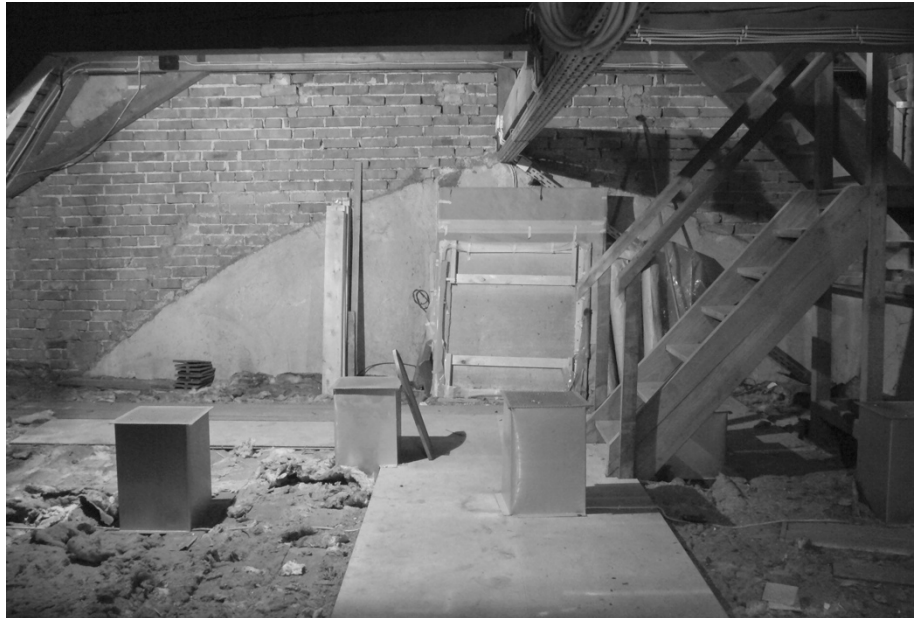
Abb. 64 Rundbogen im Dachstuhl
