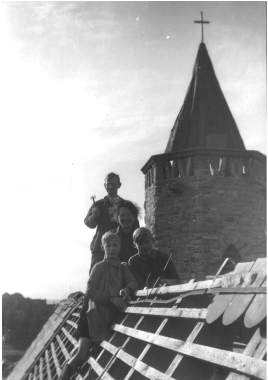
Abb. 35 Dachreparatur Herbst 1944, stehend Pfarrer Breucha, im Hintergrund der alte Turmhelm
